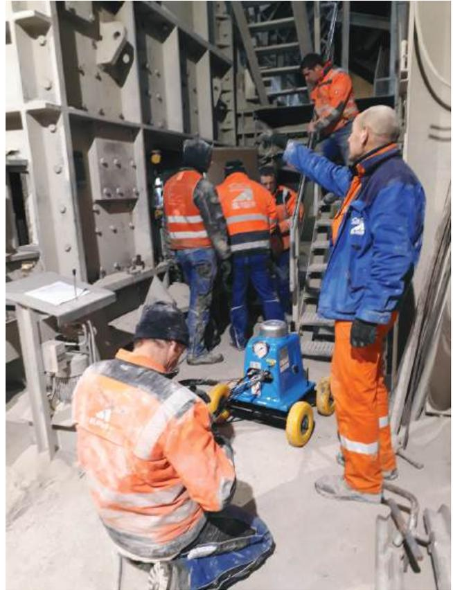
Arbeiten im Steinbruchbetrieb an einer Steinbrecheranlage. Zu sehen eine AKSTP56 mit Hartgummirollen
